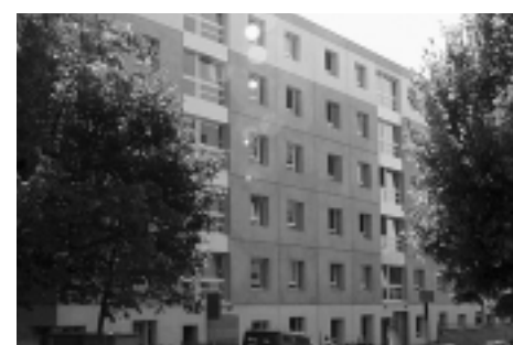
«Le Pré des Esserts», 42 appartements 9-9b rue des Esserts.
