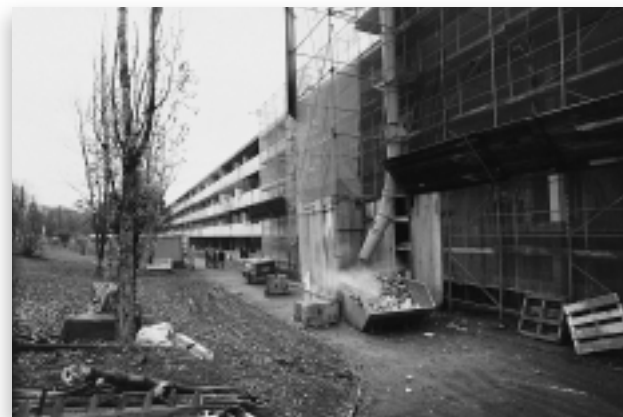
Le chantier s'est installé aux n° 89 et 90
